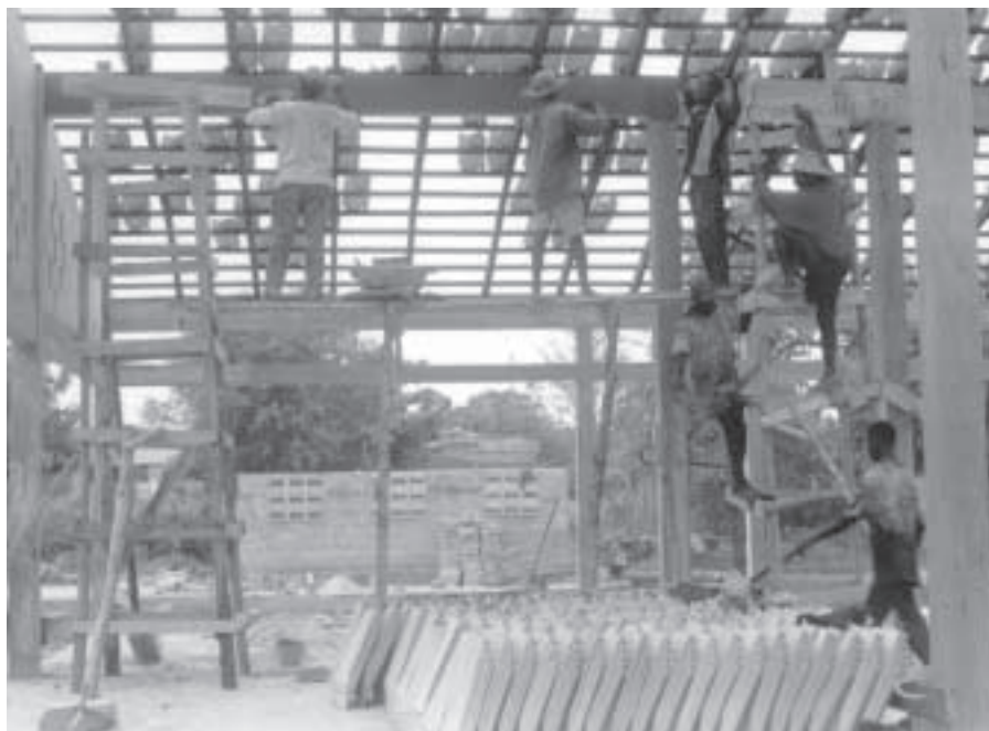
Les toits des marchés ont été recouverts de tuiles produites localement. Les murs ont été construits avec des briques d'argile extraite directement sur le site.
