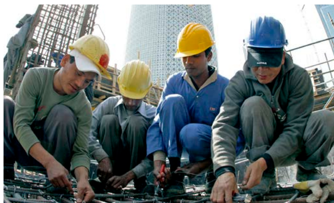
Des travailleurs migrants attachent des tiges métalliques sur un chantier de construction du Qatar. © OIT/Apex Image
