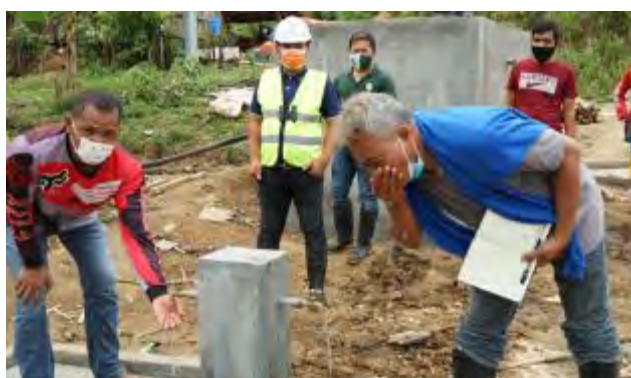
Tap stand inspection in Rifao, N. Upi, Maguindanao.
