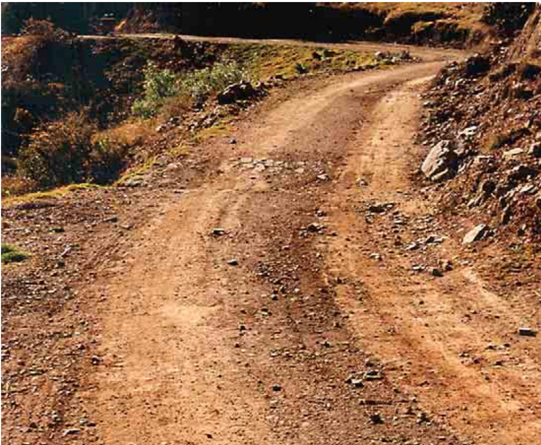
Figura 12: Camino con presencia de baches
