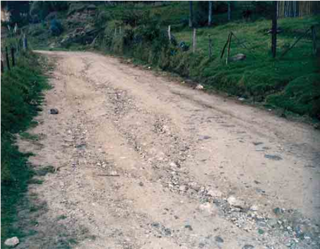
Figura 12: Camino con presencia de baches
