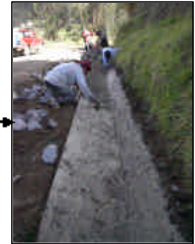
Revestimiento de la Cuneta
