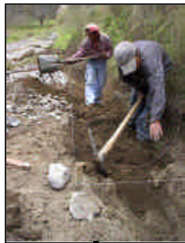
Excavación y Conformación de la Cuneta
