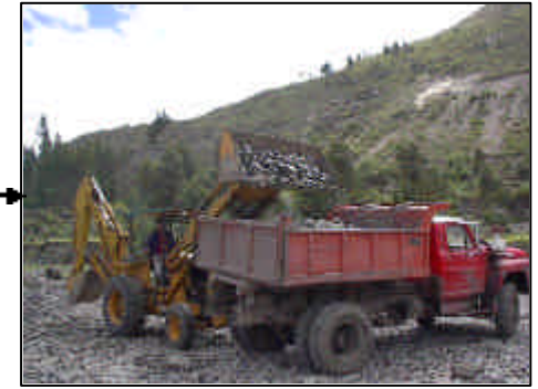
Carga de Material a Volqueta
