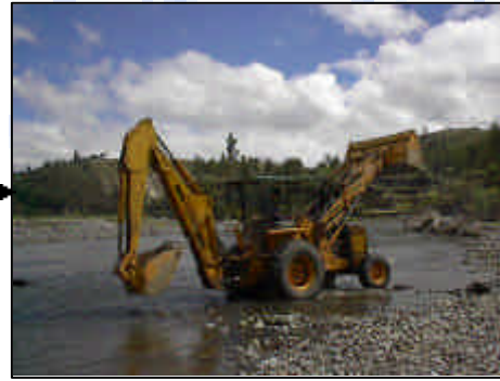
Transporte de Material a volqueta
