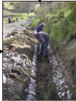
Colocación de Maestras o Cordones Maestros
