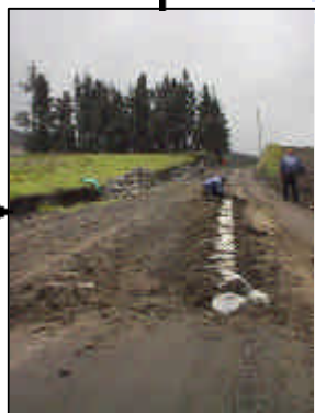
Colocación de Maestras o Cordones Maestros
