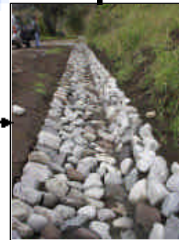
Hincado de piedra
