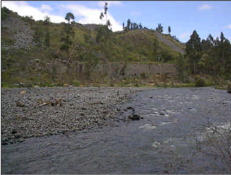
Fuente de material a orillas del Río
