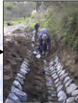
Colocación de piedra
