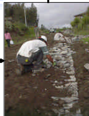
Hincado de piedra
