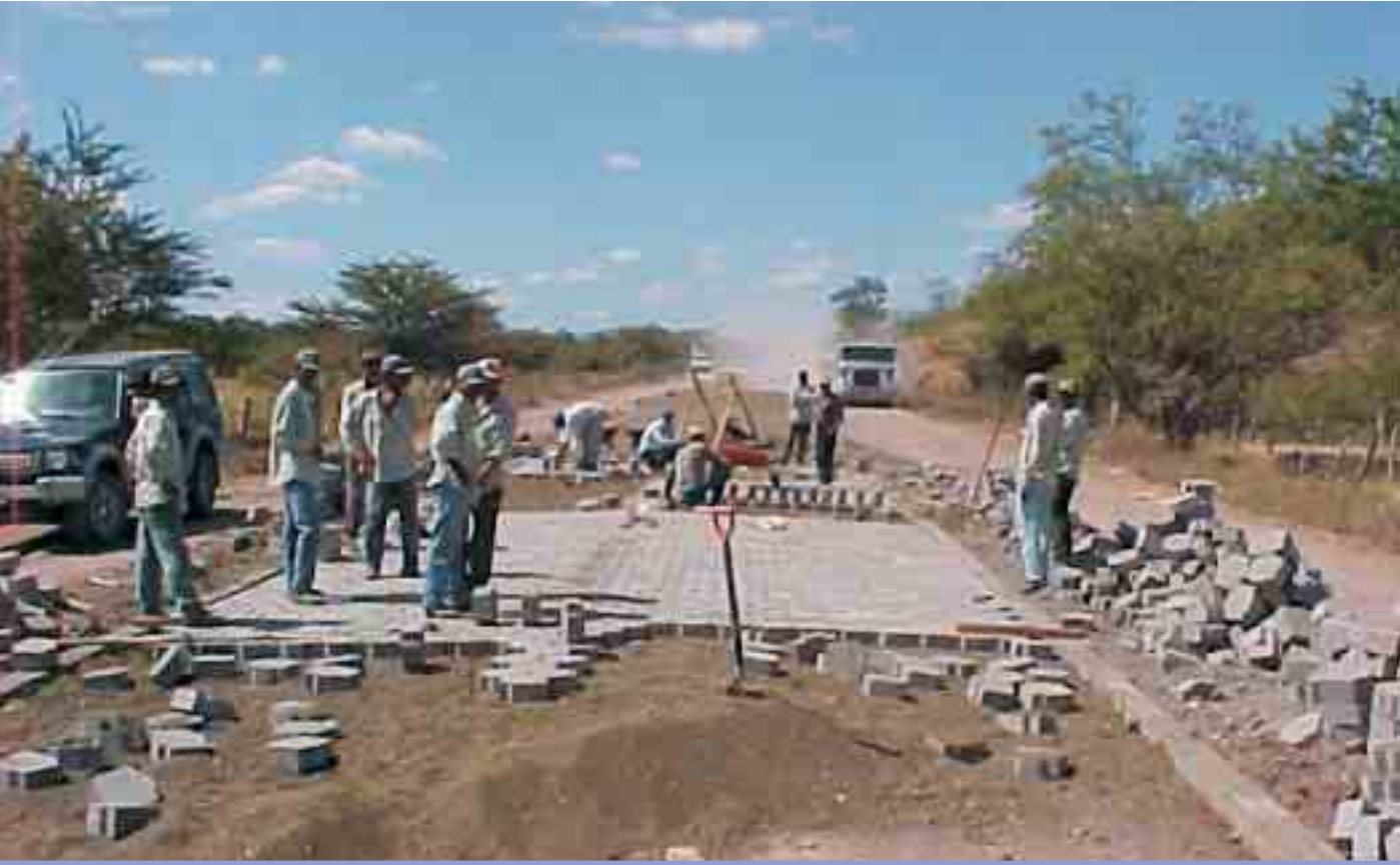
Nicaragua : construction d'une route en pavés avec des "adoquines"
