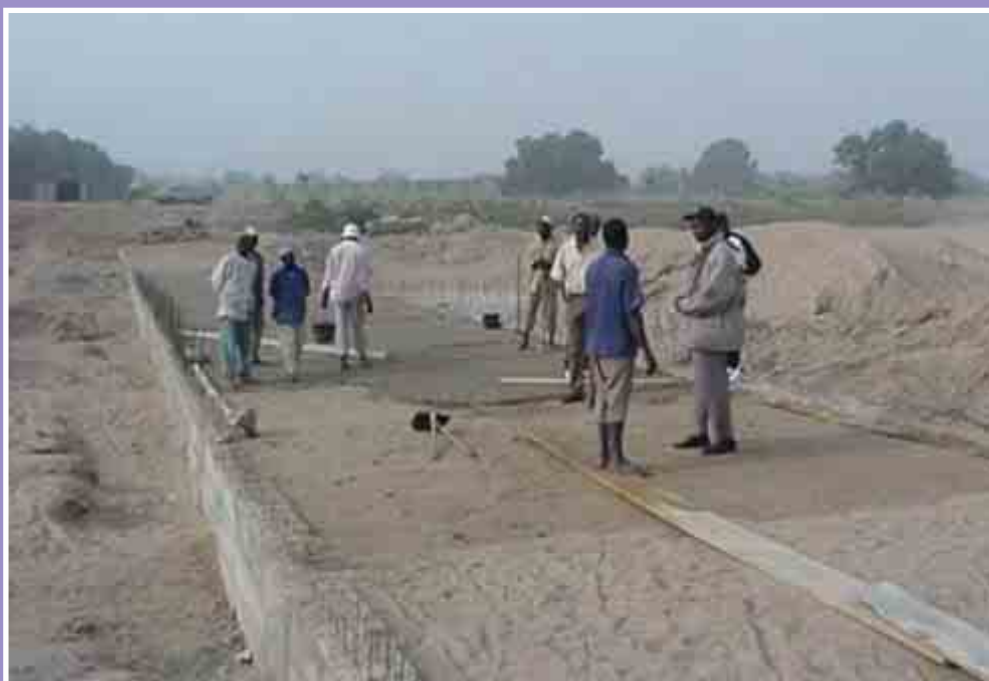
Cameroon: Construction d'un radier
