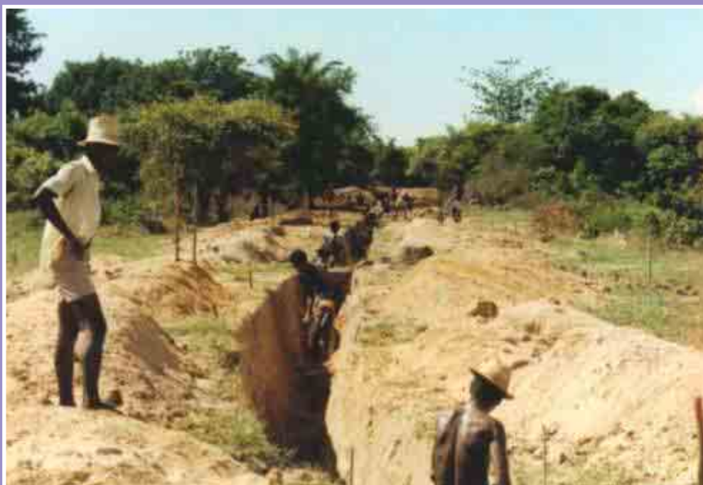
Madagascar: Construction d'un canal d'irrigation. Programme de coopération du BIT
